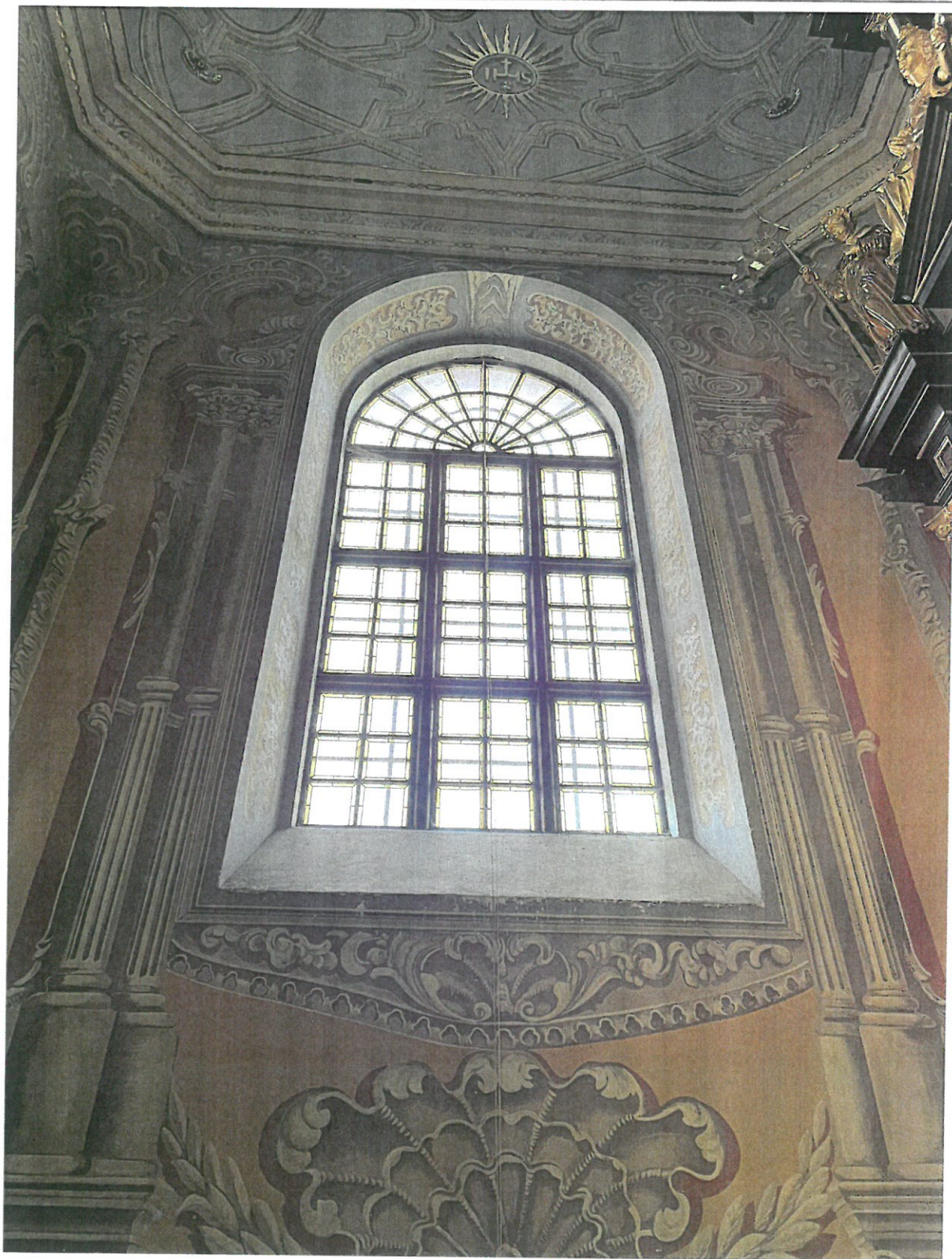
Fot. 5. Okno dziewięciu kwatrowe z dekoracją witrażową, nawa północna, bazylika p.w. Najświętszej Marii Panny w Leżajsku, stan obecny.
