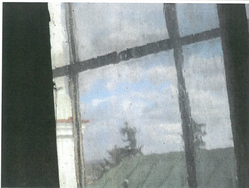
Fot. 8. Oryginalne szklenie, szybka górnej kondygnacji.
