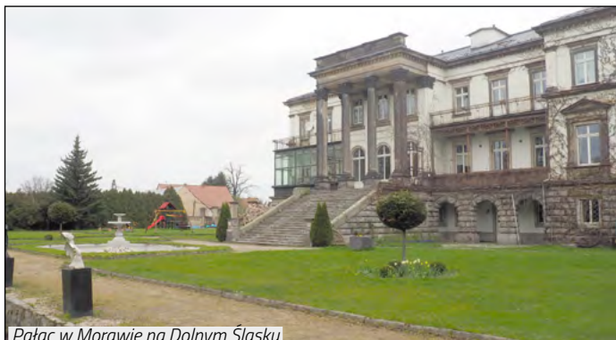
Pałac w Morawie na Dolnym Śląsku
