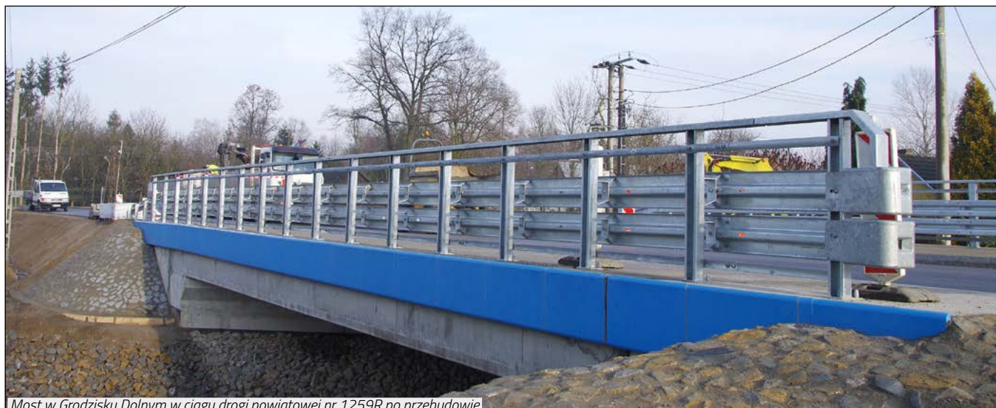
Most w Grodzisku Dolnym w ciągu drogi powiatowej nr 1259R po przebudowie
