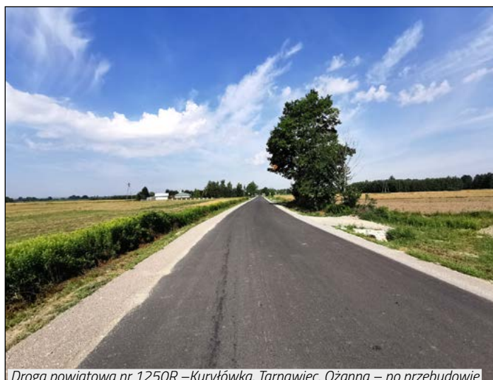
Droga powiatowa nr 1250R – Kuryłówka, Tarnawiec, Ożanna – po przebudowie
