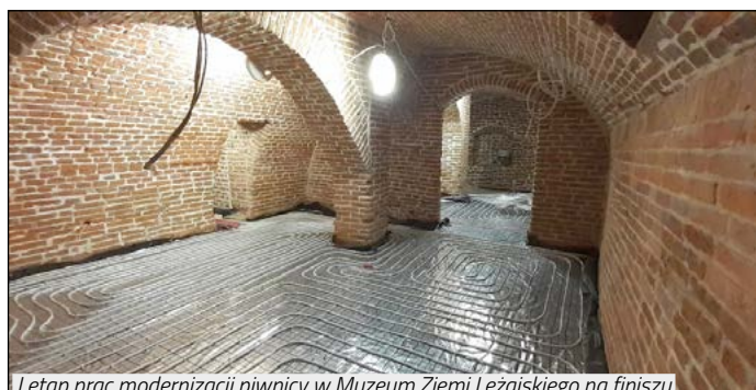
I etap prac modernizacji piwnicy w Muzeum Ziemi Leżajskiego na finiszu
