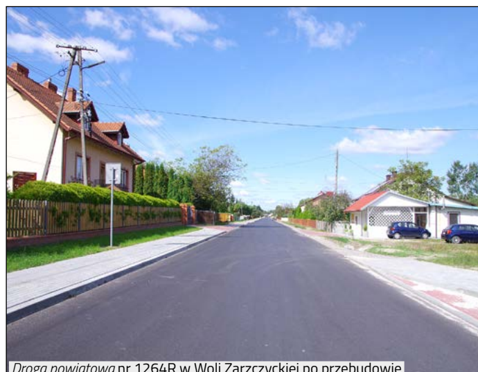
Droga powiatowa nr 1264R w Woli Zarzyczyńskiej po przebudowie
