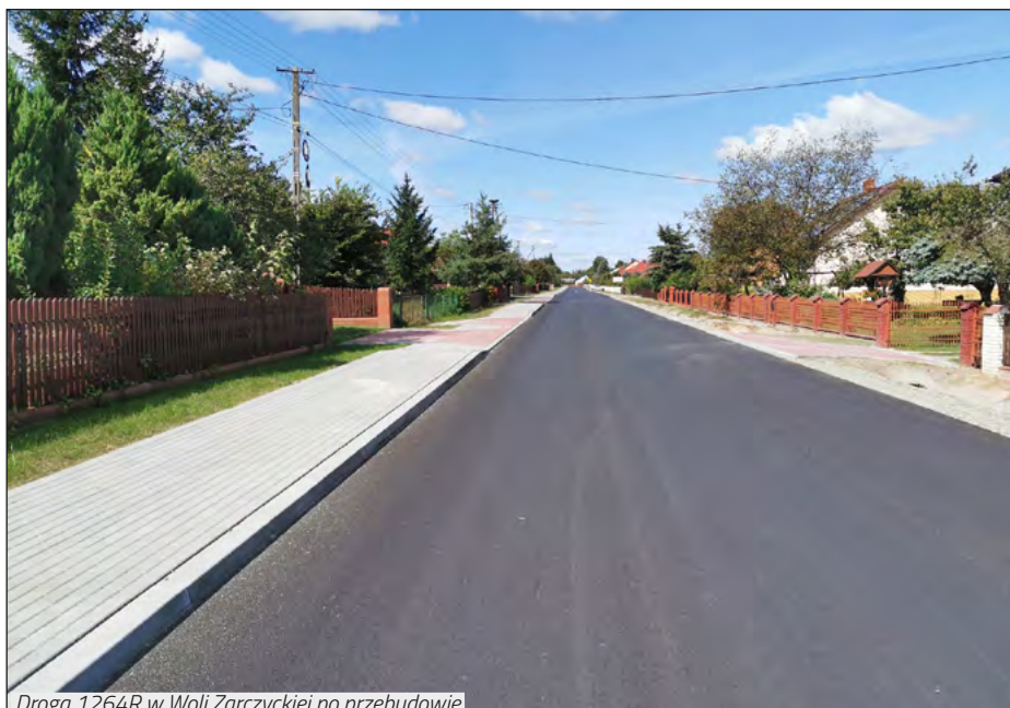
Droga 1264R w Woli Zarczyckiej po przebudowie
