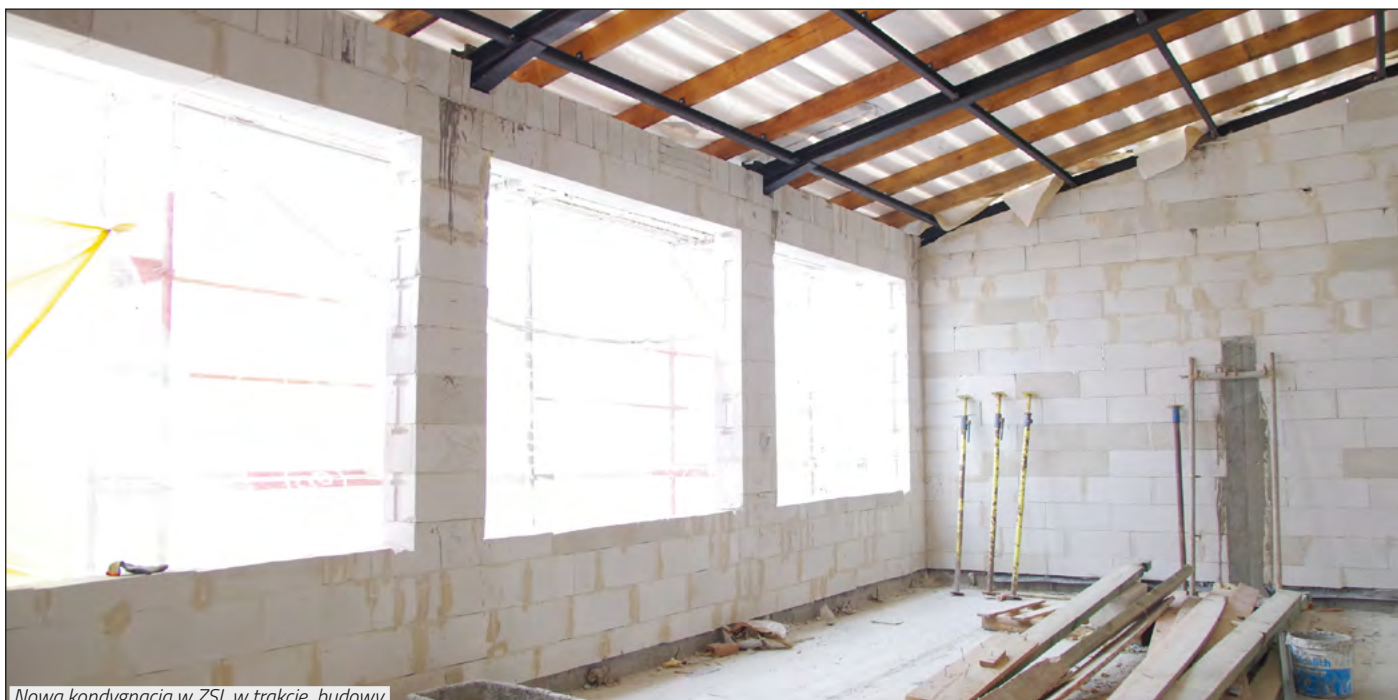
Nowa kondygnacja w ZSL w trakcie budowy.
