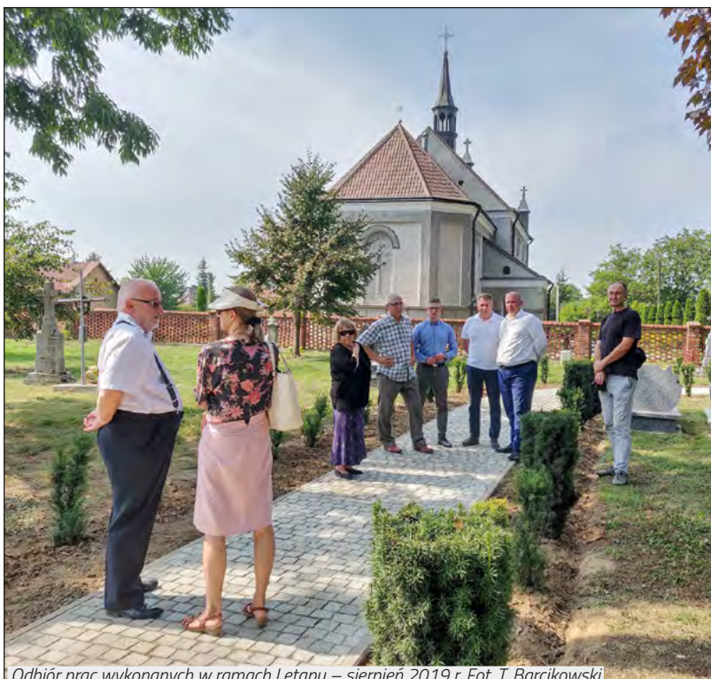
Odbiór prac wykonanych w ramach I etapu – sierpień 2019 r. Fot. T. Barcikowski
