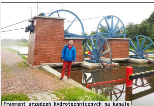
Fragment urządzeń hydrotechnicznych na kanale
