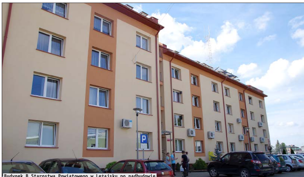
Budynek B Starostwa Powiatowego w Leżajsku po nadbudowie
