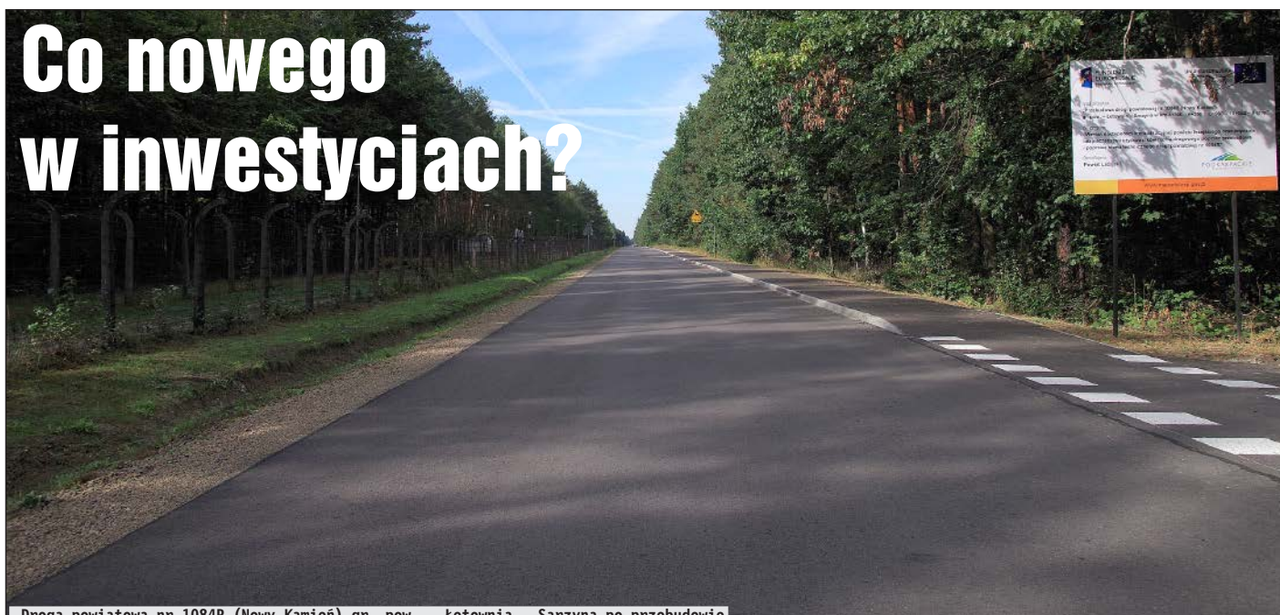
Droga powiatowa nr 1084R (Nowy Kamień) gr. pow. – Łętownia – Sarzyna po przebudowie
