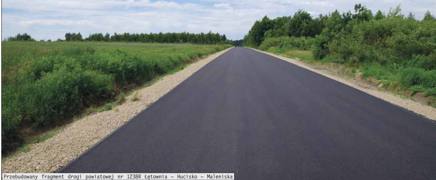
Przebudowany fragment drogi powiatowej nr 1238R Łętownia – Hucisko – Maleniska
