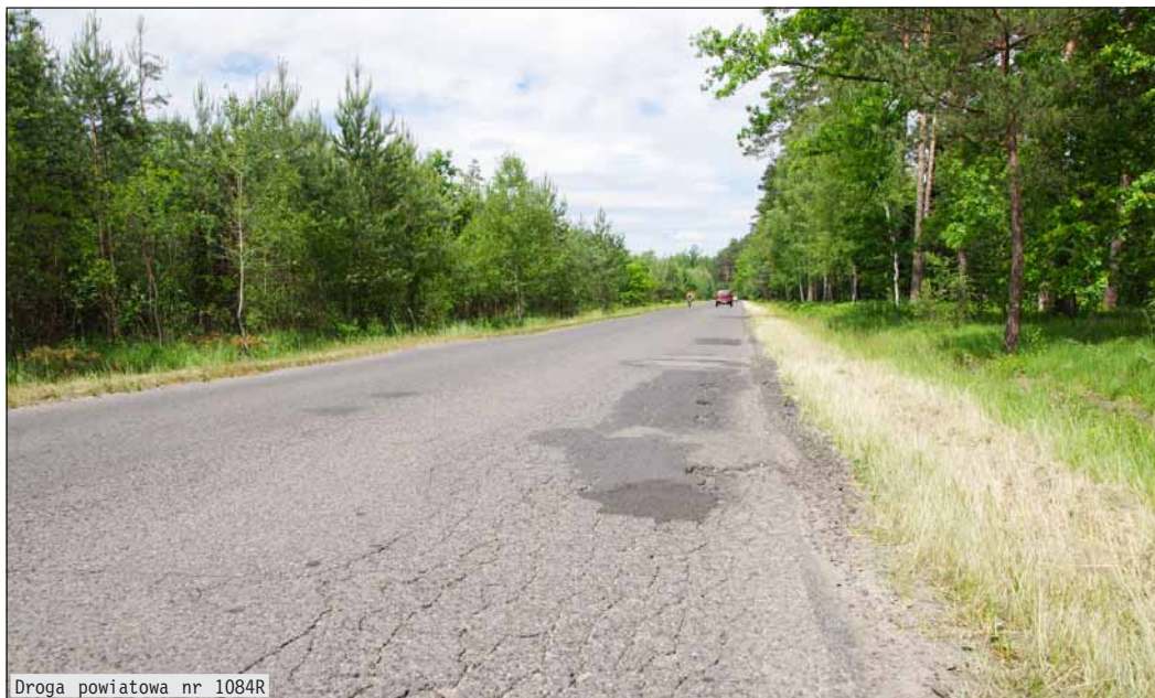
Droga powiatowa nr 1084R (Nowy Kamień) gr. pow. – Łętownia - Sarzyna (stan przed rozpoczęciem przebudowy)
