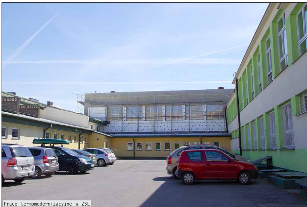
Prace termomodernizacyjne w ZSL
