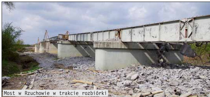
Most w Rzuchowie w trakcie rozbiórki
