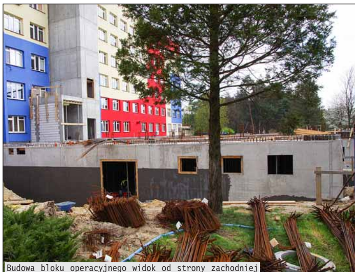
Budowa bloku operacyjnego widok od strony zachodniej
