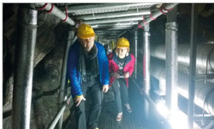
Trzeci tunel odkryty w latach 30-tych.
