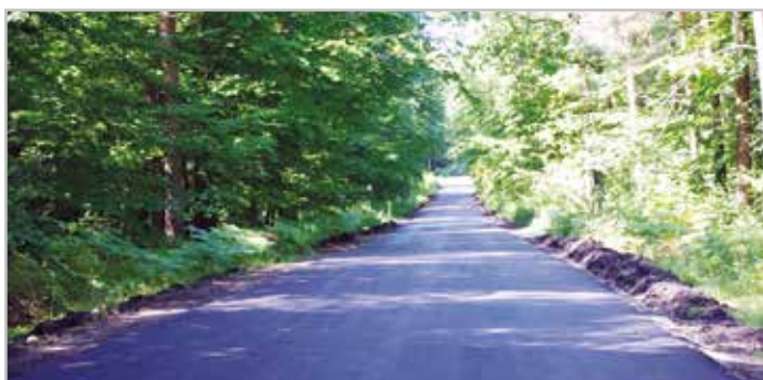
Droga w Brzozie Królewskiej po remoncie
