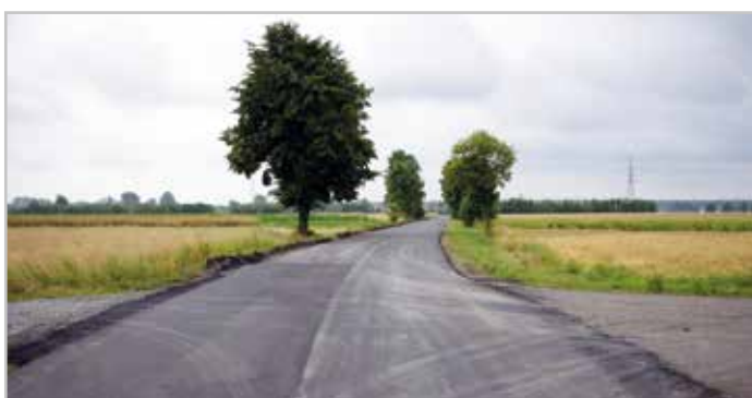
Droga w Przychojcu po remoncie
