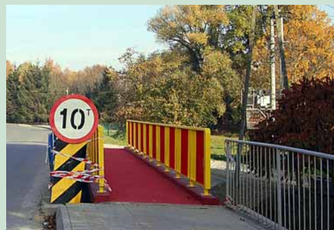
▲ Nowa kładka na potoku Grodziszczanka.
