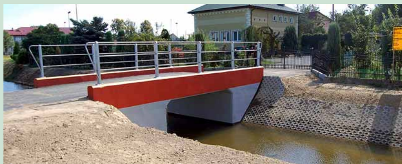
▲ Przebudowany most w Grodzisku Górnym.
