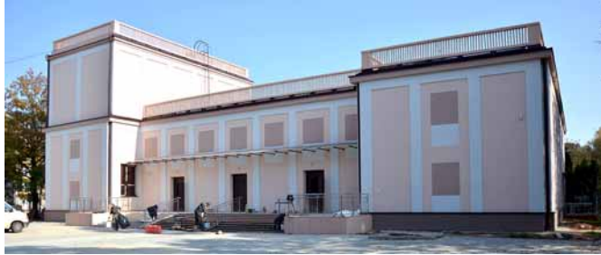
▲ Remont budynku Ośrodka Kultury.
