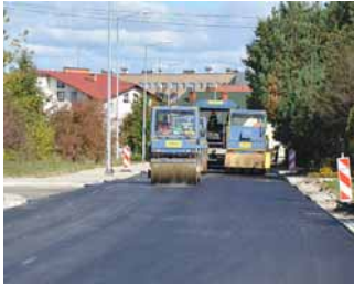
▲ Przebudowa ul. A. Pontyjskiej w Nowej Sarzynie.
