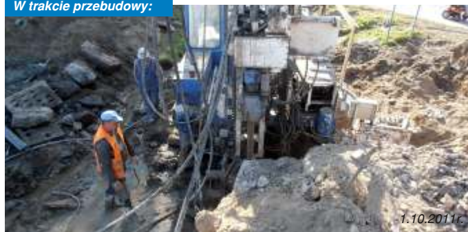
W trakcie przebudowy:
