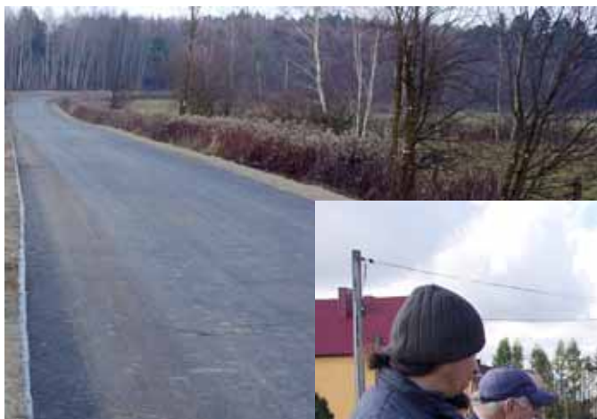
▲ Przebudowany odcinek drogi powiatowej nr 1254R Ożanna – Piskorowice.
