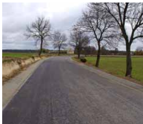
▲ Przebudowany odcinek drogi powiatowej nr 1326R Piskorowice – Chałupki Piskorowickie.
