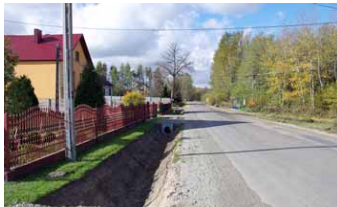
▲ Wyremontowany odcinek drogi powiatowej nr 1247R Brzyska Wola – Kolonia Polska.
