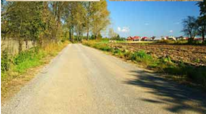
▲ Jak zawsze najbardziej wyczekiwany inwestycjami przez wszystkich mieszkańców są wszelkiego rodzaju remonty dróg. I tak w roku bieżącym wykonano remont ciągu dróg wewnętrznych
