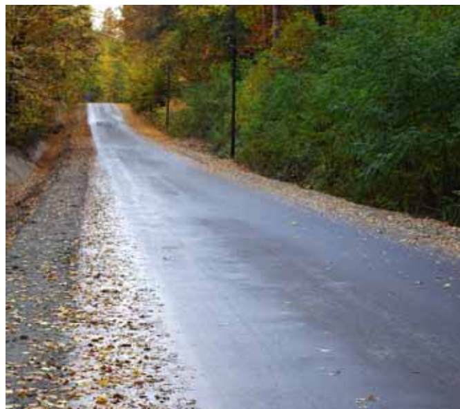
▲ Przebudowany odcinek drogi powiatowej nr 1269R Zmysłówka – Grodzisko Dolne.
