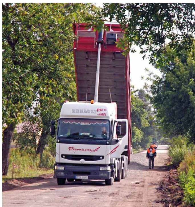
▲ Remont drogi powiatowej nr 1326R w Chałupkach Piskorowickich
