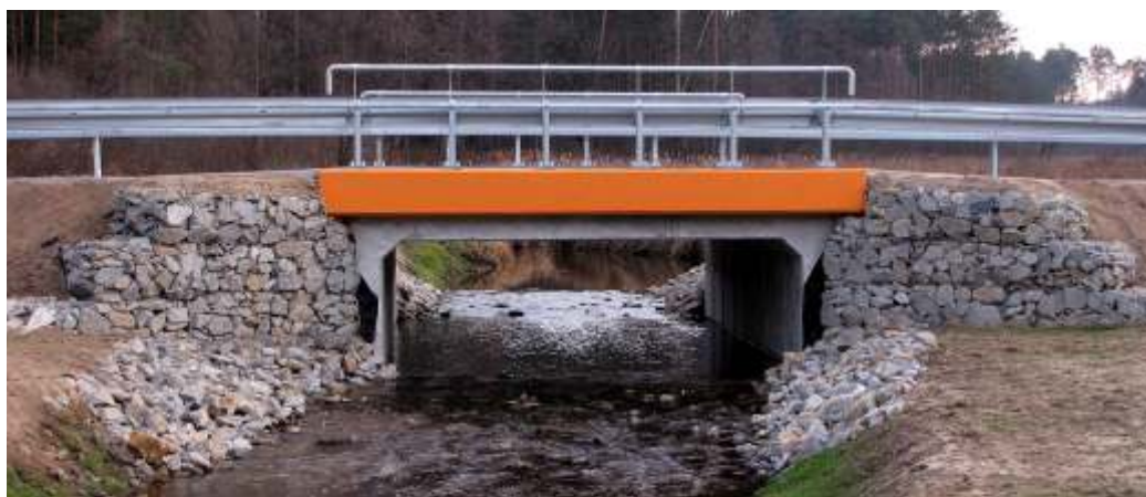
ZCZ ▲ Most po remoncie.
