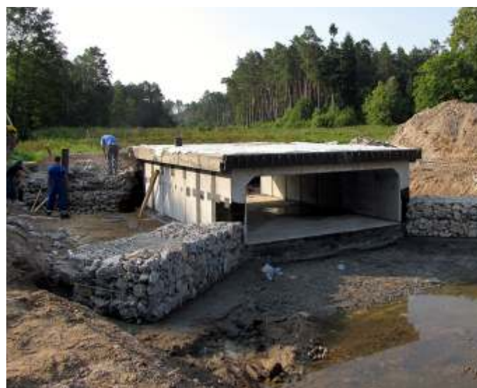
▲ W trakcie remontu – sierpień 2011 r.
