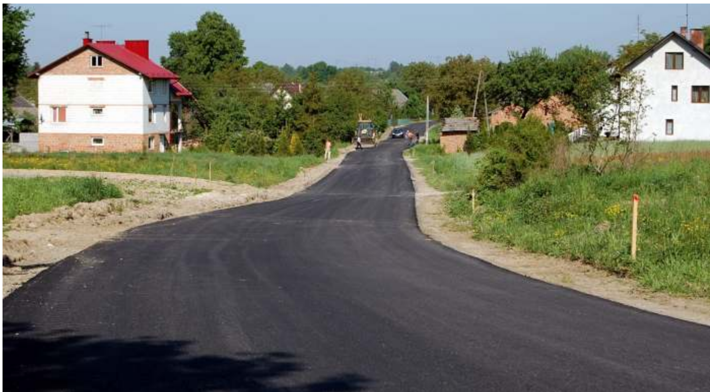
▲ Remont drogi „Na Góry”.
