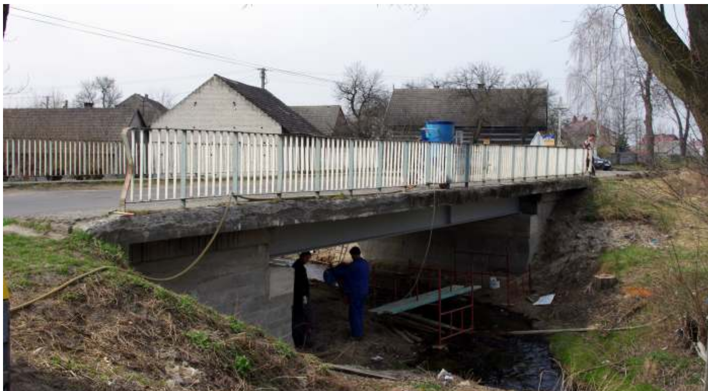
▲ Most na rzece Błotnia w trakcie modernizacji.
