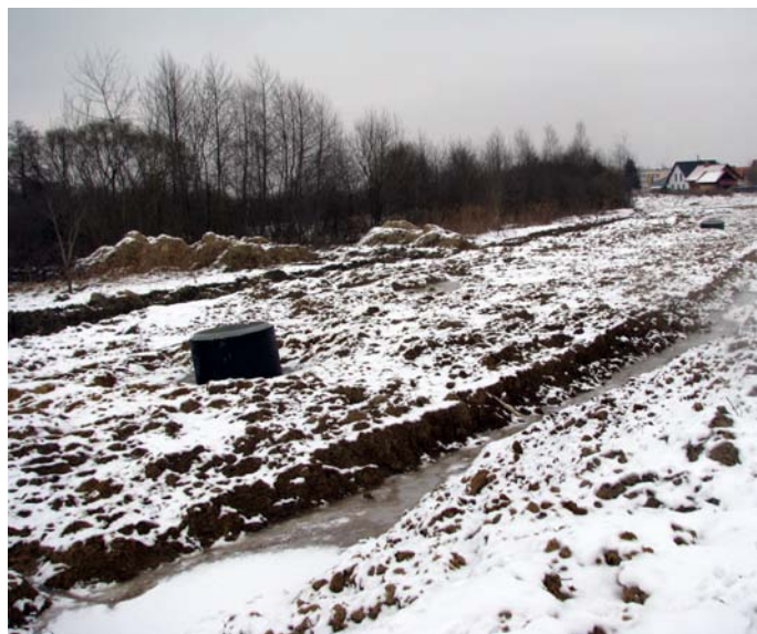
▲ Łącznik do obwodnicy – w budowie.
