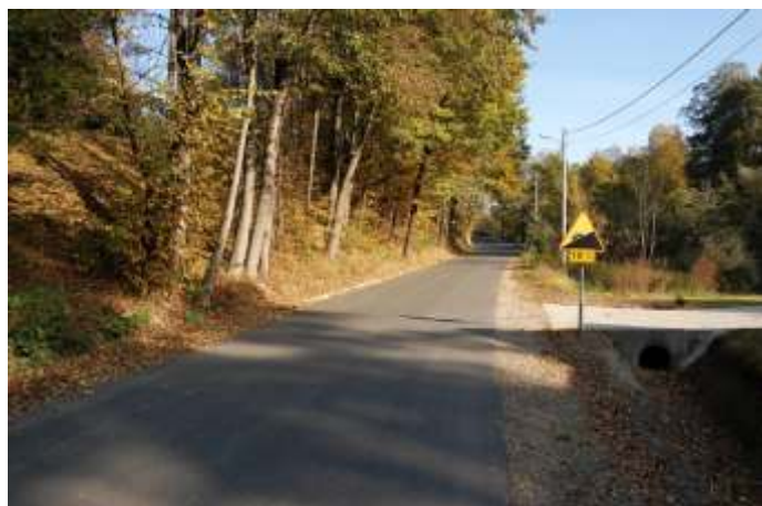
▲ Przebudowana droga gminna „Na Góry” w Grodzisku Dolnym i Grodzisku Górnym wraz z budową mostu na potoku Grodziszczanka. Koszt inwestycji: 1,4 mln zł. Pozyskane środki: 787 540 zł
