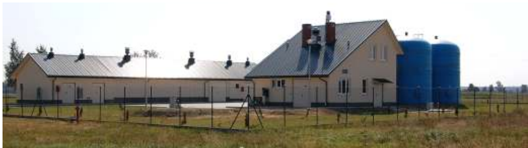
▲ Oczyszczalnia ścieków w Chodaczowie wraz z siecią kanalizacji sanitarnej w Grodzisku Nowym i Chodaczowie. Oczyszczalnia składa się z pompowni ścieków, budynku technicznego, budynku technologicznego, pomieszczenia do magazynowania odpadów. Koszt inwestycji: 10,5 mln. Pozyskane środki: 7 379 323 zł.
