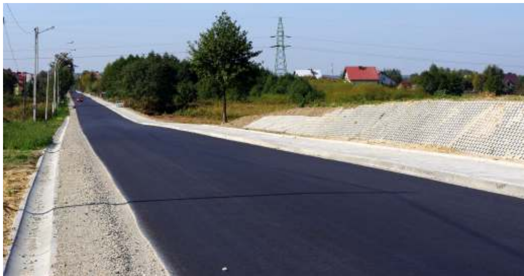
▲ Odcinek przebudowanej drogi pomiędzy Wierzawicami i Leżajskiem
