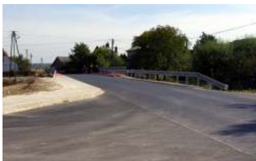
RI ▲ Wyremontowany most w miejscowości Wierzawice
