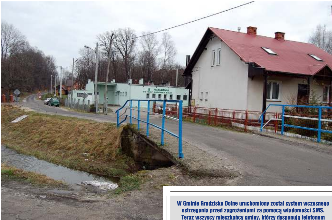
▲Przebudowa drogi i mostu ruszy na wiosnę
