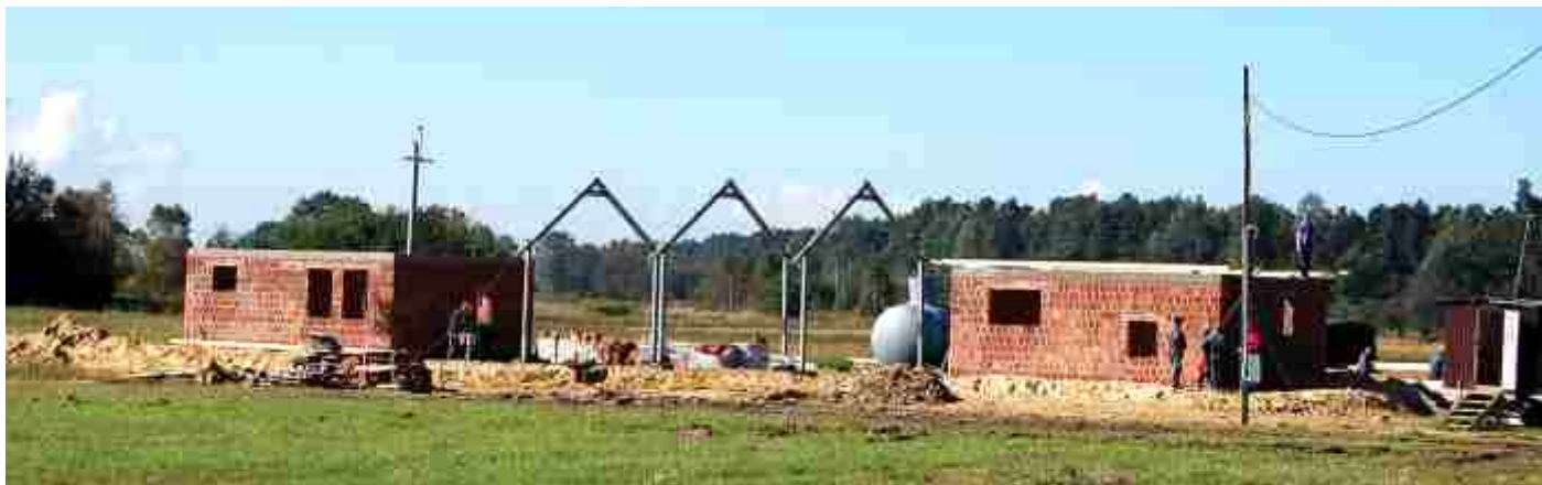
▲ W Laszczynach powstaje nowoczesna oczyszczalnia ścieków.
