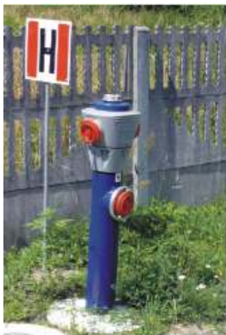
▲ W ramach inwestycji zamontowano 68 hydrantów.
