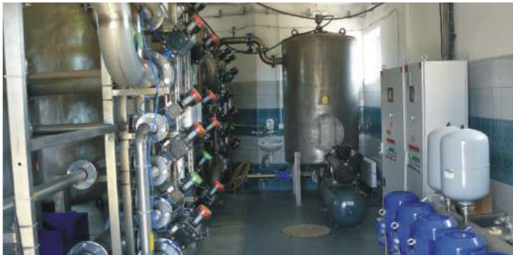
▲ Wyremontowany budynek Stacji Uzdatniania Wody
