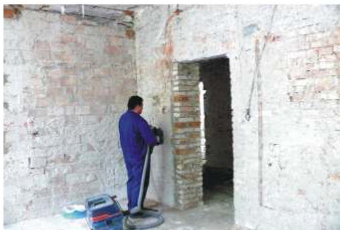
▲ Remont budynku po byłym przedszkolu nr 3 w Nowej Sarzynie
