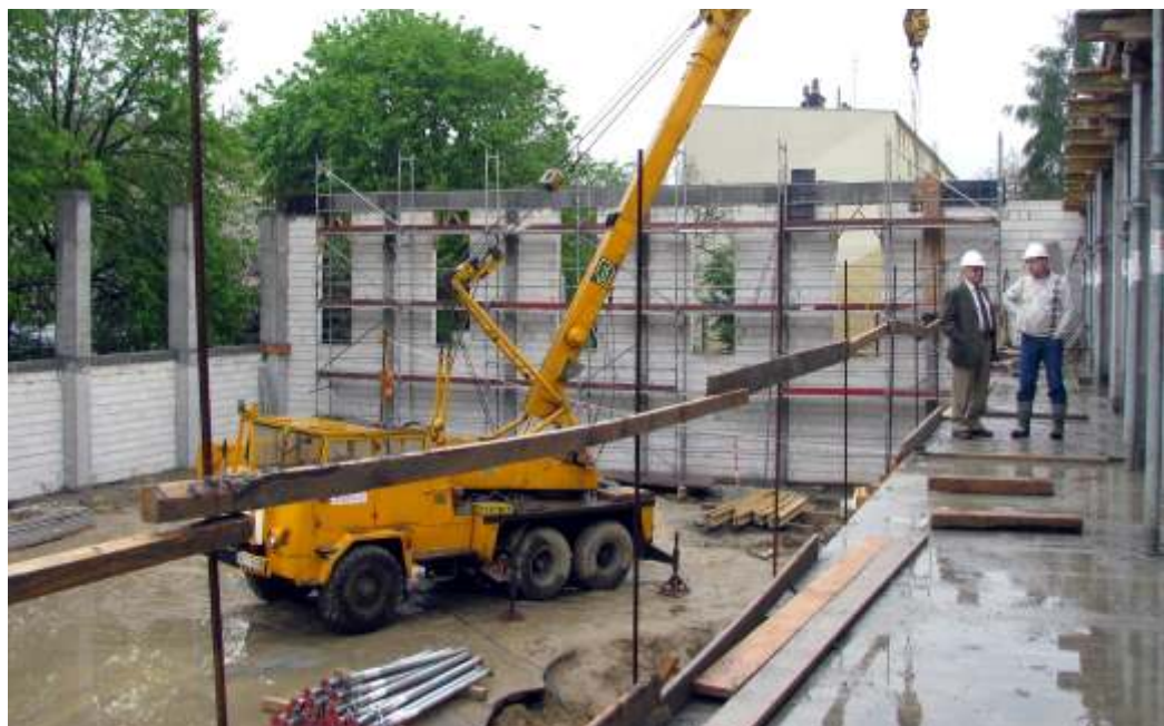
▲ Budowa hali sportowej Szkoły Podstawowej nr 2 w Leżajsku, w głębi Piotr Urban – zastępca burmistrza Leżajska i Waldemar Śmiałek – kierownik budowy „Integral-Rzeszów”.
