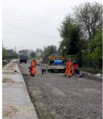
▲ Budowa drogi łączącej Podolszyny z Siedlanką.
