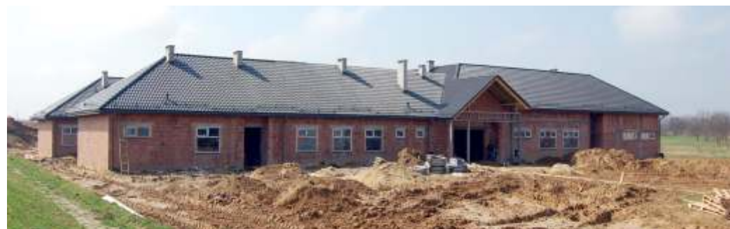
▲Budynek szkoły w Wólce Grodziskiej pokryto dachem i zamontowano okna.
