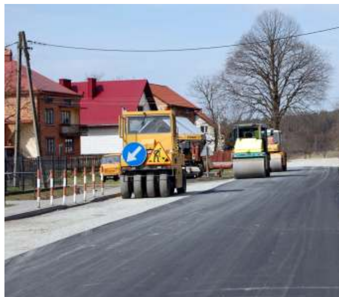
▲Modernizowany odcinek drogi obok szkoły w Opaleniskach
