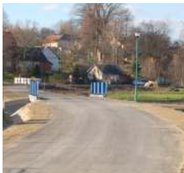
▲ Przebudowany most koło remizy OSP w Grodzisku Dolnym – koszt inwestycji: 274 576 zł. Pozyskane środki 100 tys. zł. Łącznie na terenie gminy przebudowano 2 mosty gminne i 2 powiatowe
