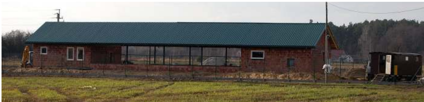
▲ Budowa sieci kanalizacyjnej w Grodzisku Nowym i Chodaczowie wraz z budową oczyszczalni ścieków w Chodaczowie – koszt inwestycji: 10,5 mln. Pozyskane środki – 7 379 323 zł
