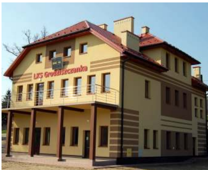
▲ Stadion i szatnia sportowa w Grodzisku Górnym – koszt inwestycji: 780 tys. zł. Pozyskane środki: 480 775 zł
