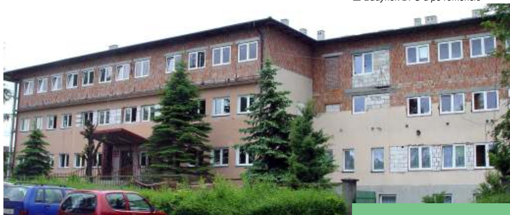
▲ Budynek w trakcie remontu
