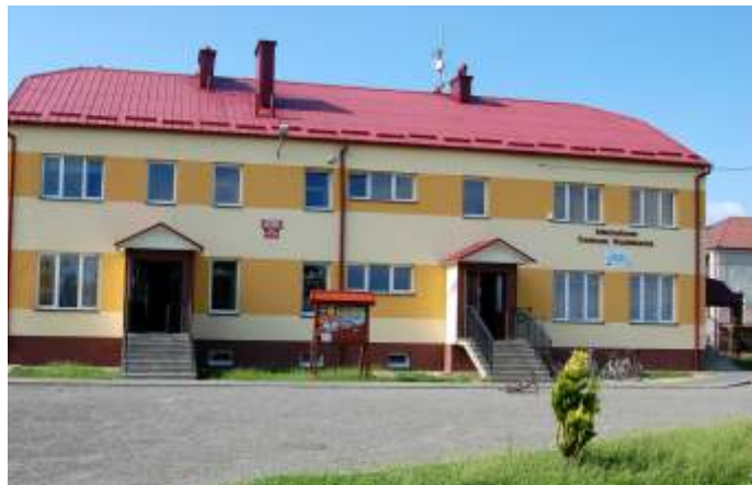
▲ Dom Wiejski w Grodzisku Nowym – koszt inwestycji: 198 tys. zł. Pozyskane środki: 97 515 zł. Termomodernizacji poddano również Remizę OSP w Chodaczowie. Wartość zadania: 309 tys. zł. Pozyskane środki: 108 875 zł
