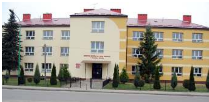
▲ Zespół Szkół w Grodzisku Dolnym – wartość inwestycji: 235 347 zł. Ogółem na terenie gminy termomodernizacji poddano jeszcze 2 obiekty szkolne, w Chodaczowie i w Laszczynach, na łączną kwotę 686 579 zł
