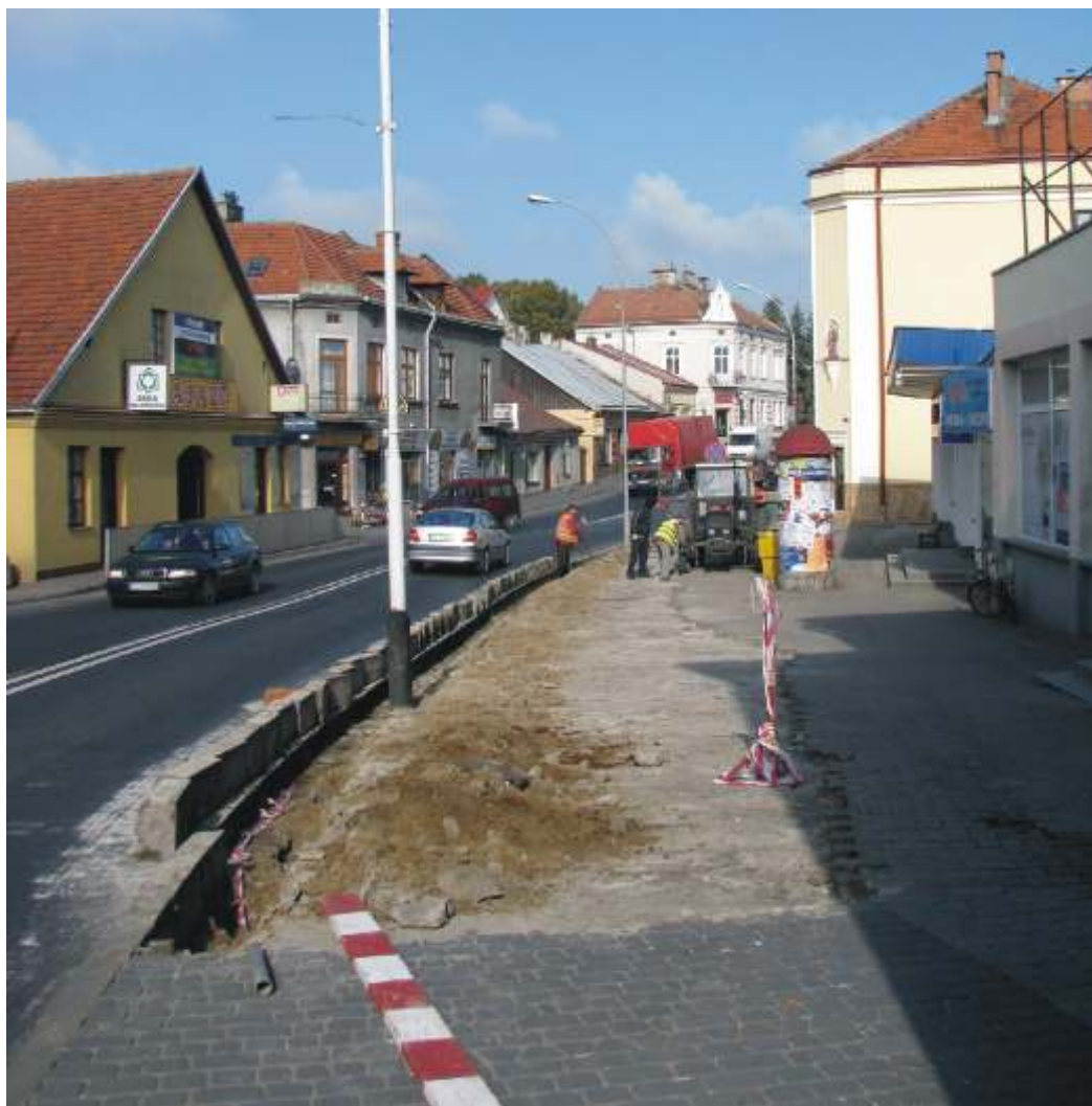
▲Remont chodnika przy ulicy Mickiewicza.
