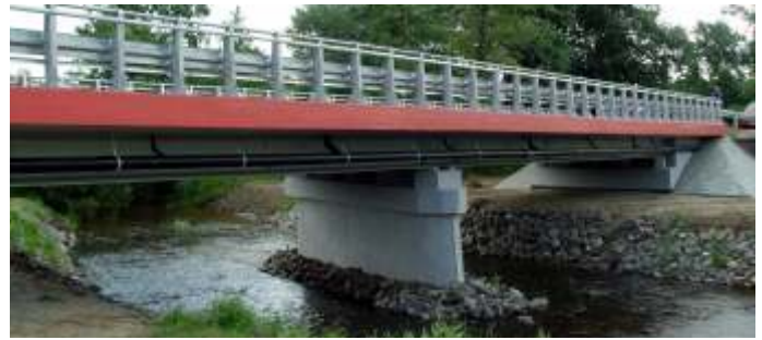
▲ Przebudowany most w Hucisku.
