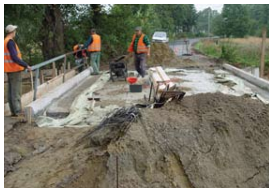
Przebudowa mostu w Chodaczowie
