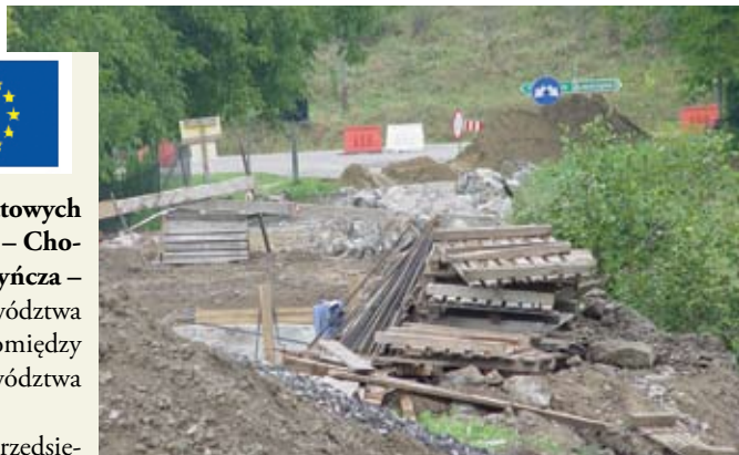
Przebudowa mostu w Grodzisku Dolnym
