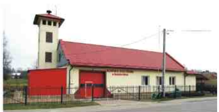
▲ Nowy dach na remizie OSP w Grodzisku Górnym
