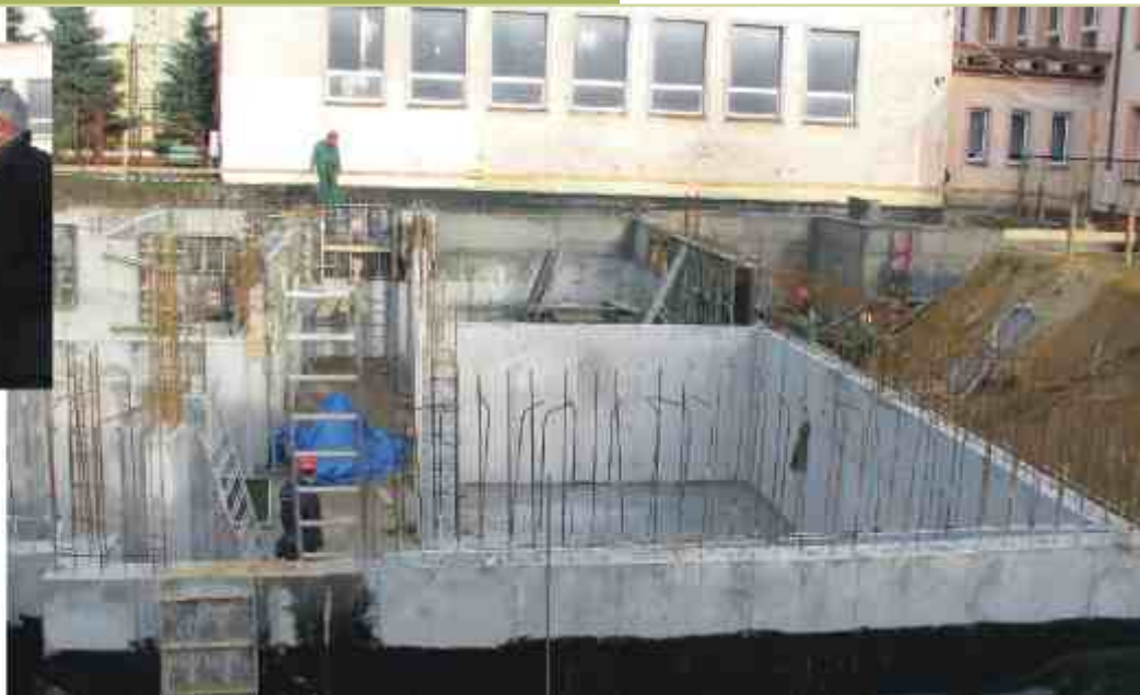
▲ Budowa sali sportowej przy SP nr 2
