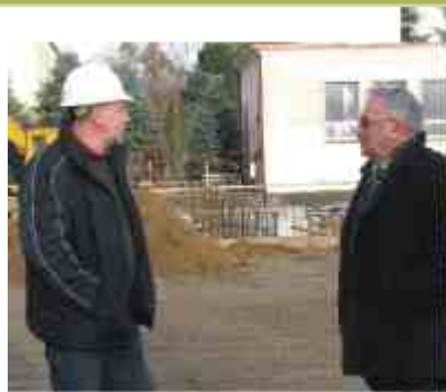
▲ Na budowie sali sportowej przy Szkole Podstawowej nr 2 - od lewej: kierownik robót inż. Waldemar Śmialek i zastępca Burmistrza Leżajska Piotr Urban
