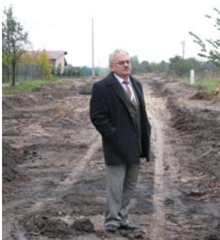
Piotr Urban na budowie drogi łączącej ulicę Podolszyny z Siedlanką.
