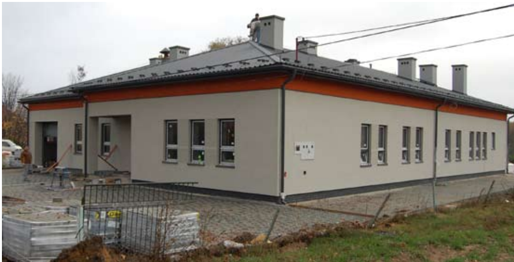
Dobiegają końca prace na zewnątrz i wewnątrz budynku placówki
