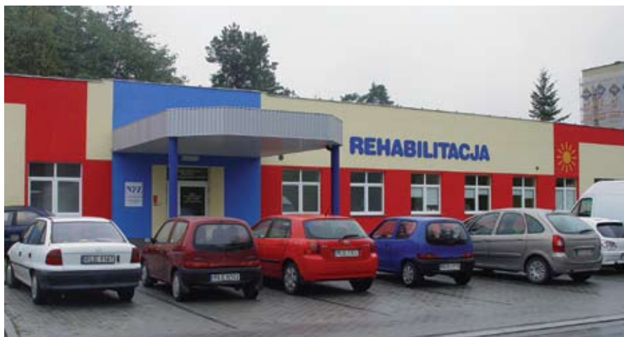
Budynek Centrum usytuowany jest przy szpitalu
