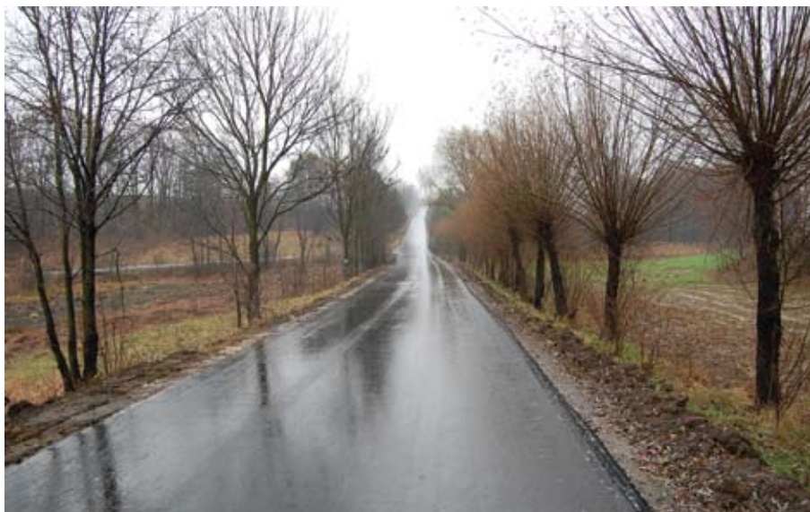
Wyremontowany odcinek drogi Grodzisko Dolne-Podlesie
