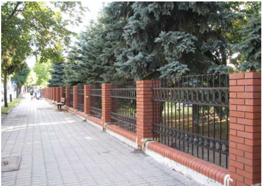
Nowe ogrodzenie Szkoły Podstawowej nr 2 od strony ulicy Mickiewicza.
