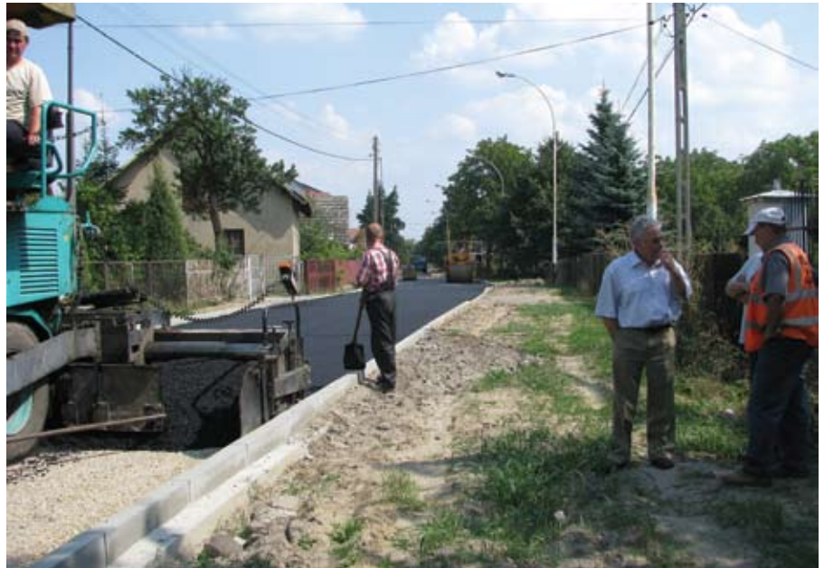
Remont ulicy Podzwierzyniec. Z prawej zastępca burmistrza Leżajska Piotr Urban w rozmowie z drogowcami.
