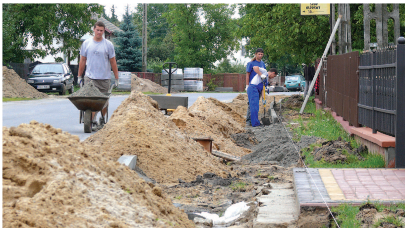
Budowa chodników w Sarzynie
