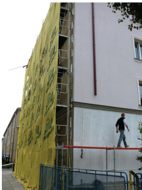
Termomodernizacja budynku UMiG w Nowej Sarzynie
