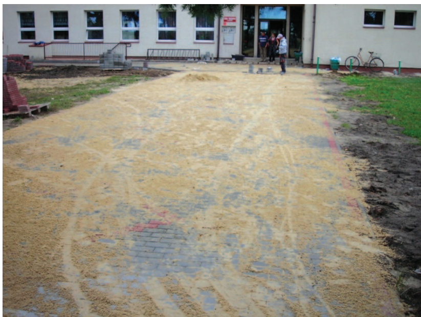
Otoczenie budynku SP w Kuryłówce
