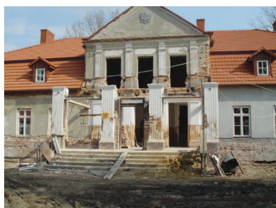
...w trakcie remontu,
