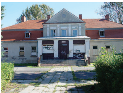
Dwór Starościński przed remontem,
