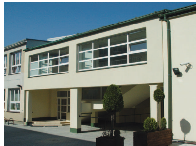
i po zakończeniu budowy
