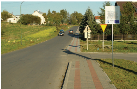
Droga Grodzisko Dolne – Chałupki Dębniańskie
