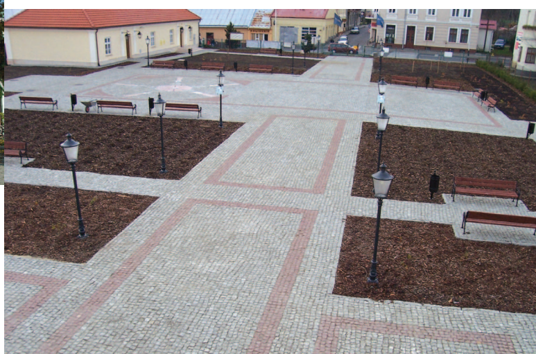
... i po remoncie
