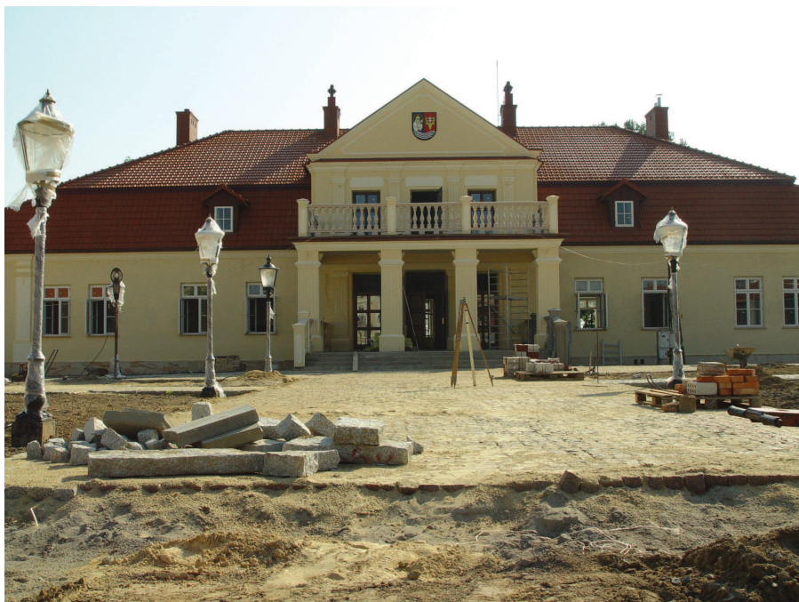
Aktualny stan prac remontowych na Dworze Starościńskim – sierpień 2007.
