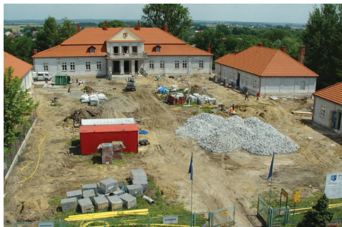
Prace remontowe. Stan: lipiec 2007r. Foto: A.CH.
