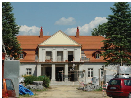
Remontowany Dwór Starościński
