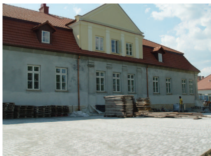
Parking od strony wschodniej Dworu
