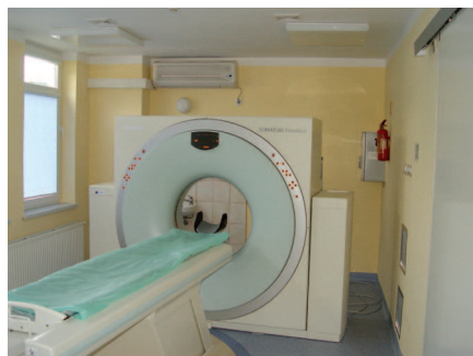
po remoncie zainstalowano tomograf
