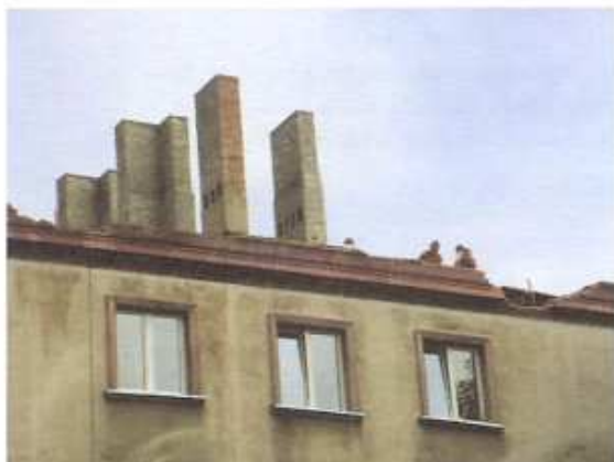
Fot. Zbigniew Janusz Po latach oczekiwani budynek Urzędu Miasta i Gminy mieć będzie nowy dach
