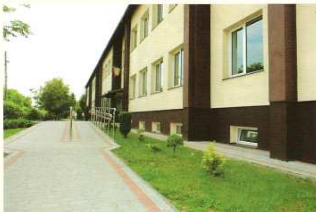
Podjazd dla niepełnosprawnych przy szkole w Starym Mieście
