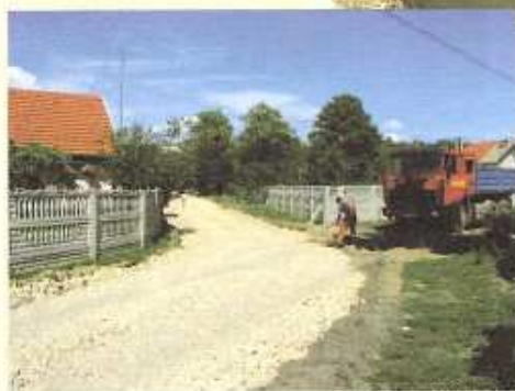
Remont drogi gminnej w Hucisku - początek robót
