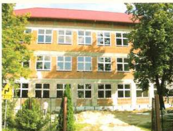
Rozbudowa szkoły w Wierzawicach
