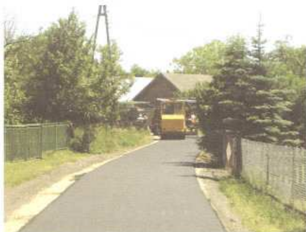
Długo wyczekiwana asfaltowa nawierzchnia drogi Na Sołtysa w Opaleniskach.
