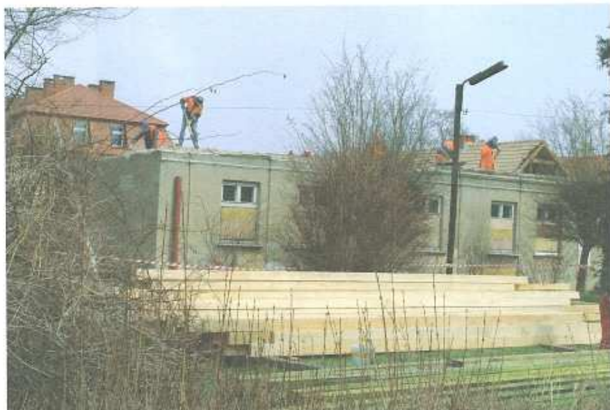
Prace remontowe prowadzone są na zewnątrz ...
