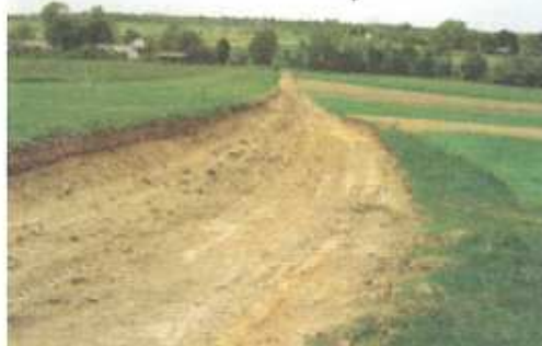
W ramach zagospodarowania poscaleniowego w Grodzisku Górnym i Wólce Grodzkiej przetarto już ponad 70 km dróg. Dzięki temu nie będzie już problemu z dojazdem do działek rolnym każdą maszyną rolniczą.
