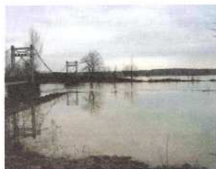
Wielka woda w rejonie kładki na Wisłoku w Chodaczowie w dniu 31 marca 2006r.
