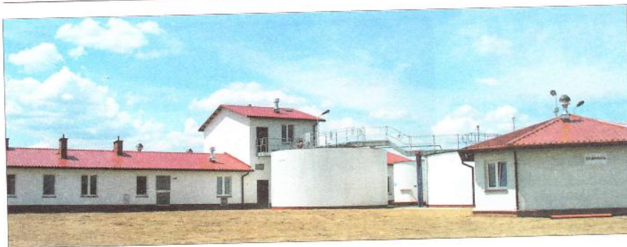
Budynki administracyjno-gospodarcze oczyszczalni wraz trójzbiornikiem oczyszczania.
