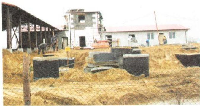
Teren budowy oczyszczalni - grudzień 2004
