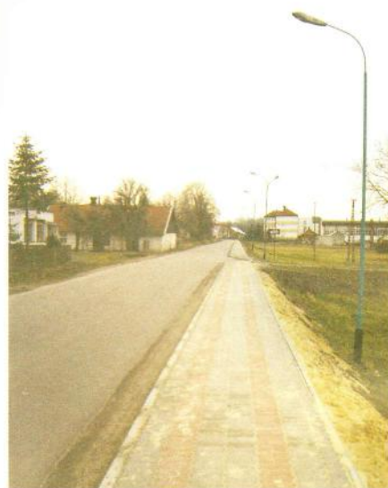
Bezpieczna droga do szkoły - to podstawowy argument przemawiający za dalszą budową chodników.
