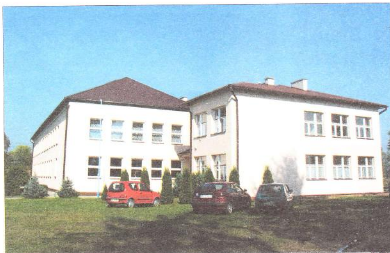
Zespół Szkół w Dębnie po wymianie okien, wykonaniu ocieplenia, nowego dachu oraz elewacji
