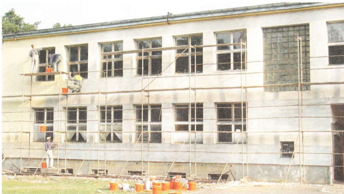
Budynek Zespołu Szkół w Nowej Sarzynie w trakcie remontu polegającego na wymianie stolarki okiennej i termomodernizacji.
