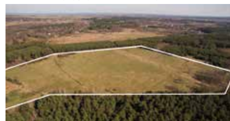
Teren inwestycyjny Malne - g. Grodzisko Dolne
